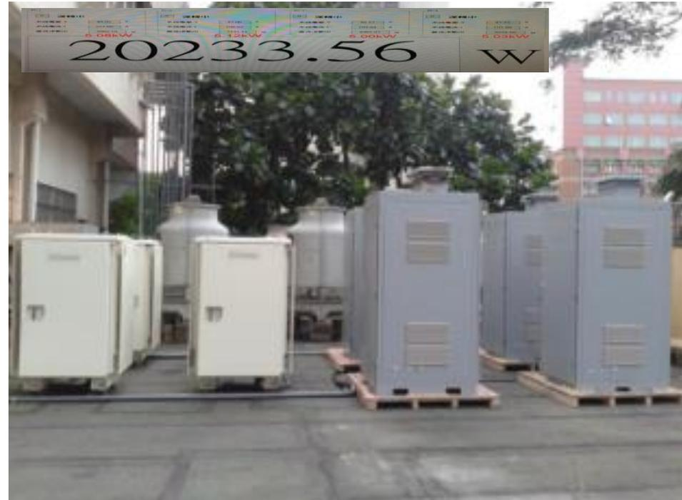
設置於國立台灣科技大學體育館，20KW 氫能熱電共生燃料電池發電系統示範站，2014
