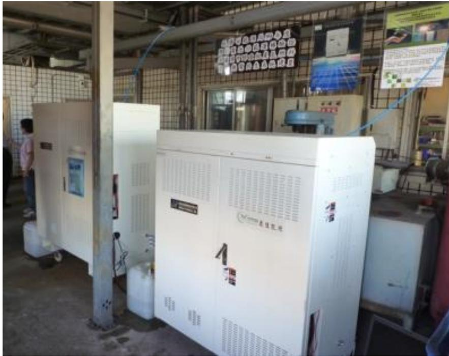
用於新北市鑄造廠的9KW的氫能燃料電池熱電共生系統，2012
