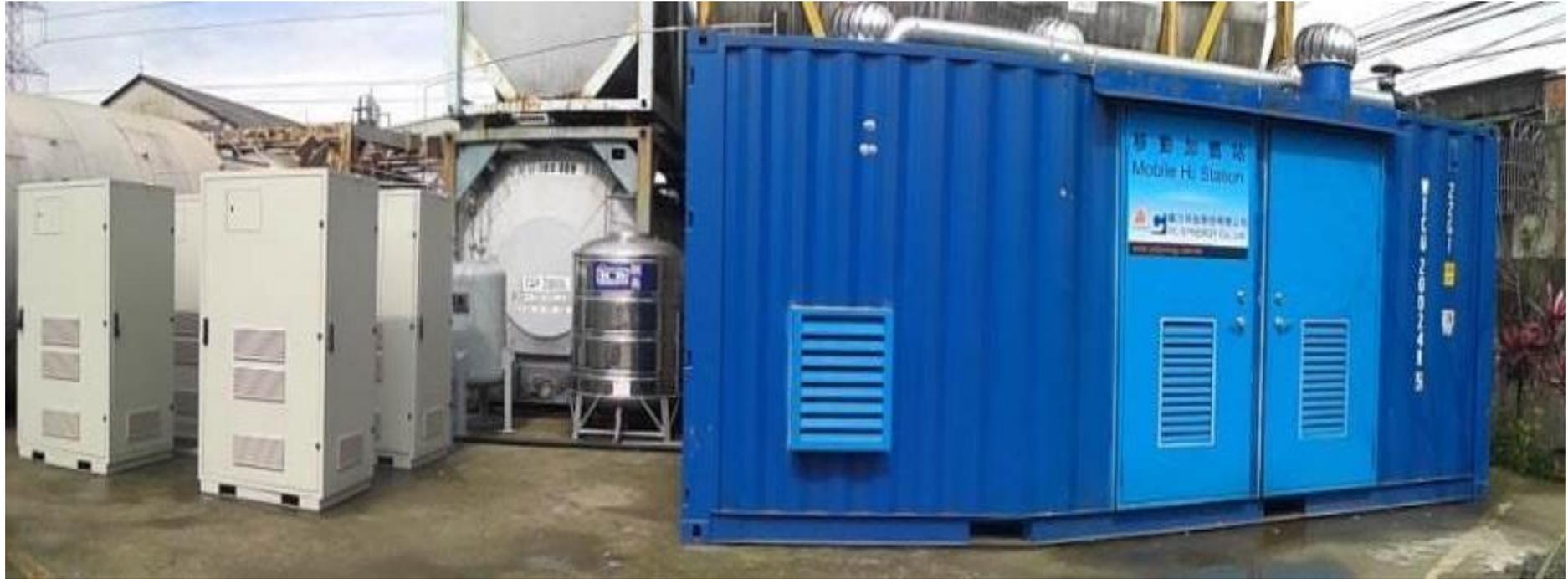
高壓氫燃料站，50 kg / D (99.9999 +%，H<sub>2</sub>，CO <1ppm)，是由4組5NMh產氫機生產氫氣，其壓力35MPa。新北市，2015年
